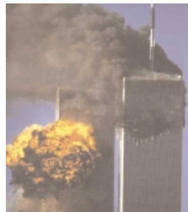
Die zweite Boing ist gerade in den Nordturm gerast. Die Hitzewelle läßt dem Gebäude keine Chance Fotos: D.J. Pallmer
