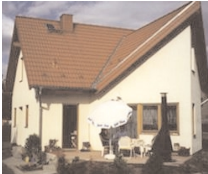
Die Freude und Erleichterung ist riesen-groß, wenn die Bauherrn-Familie die eigenen vier Wände am Grill auf der Terrasse in vollen Zügen genießen kann. Fotos: umo
